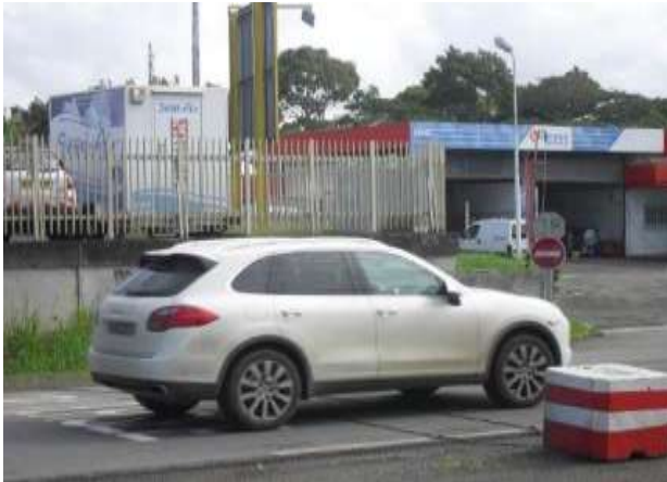
Figure 14 : Exemple de dispositif pneumatique de mesures de comptage routier
